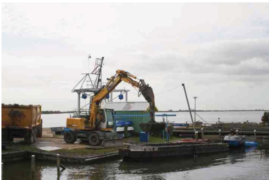
Boven, rechts en onder: baggerwerkzaamheden in volle gang.
