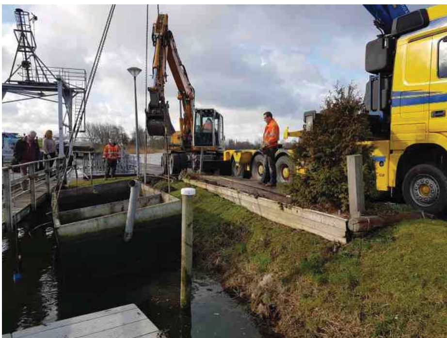
Links en boven werkzaamheden aan de opvangbak.
